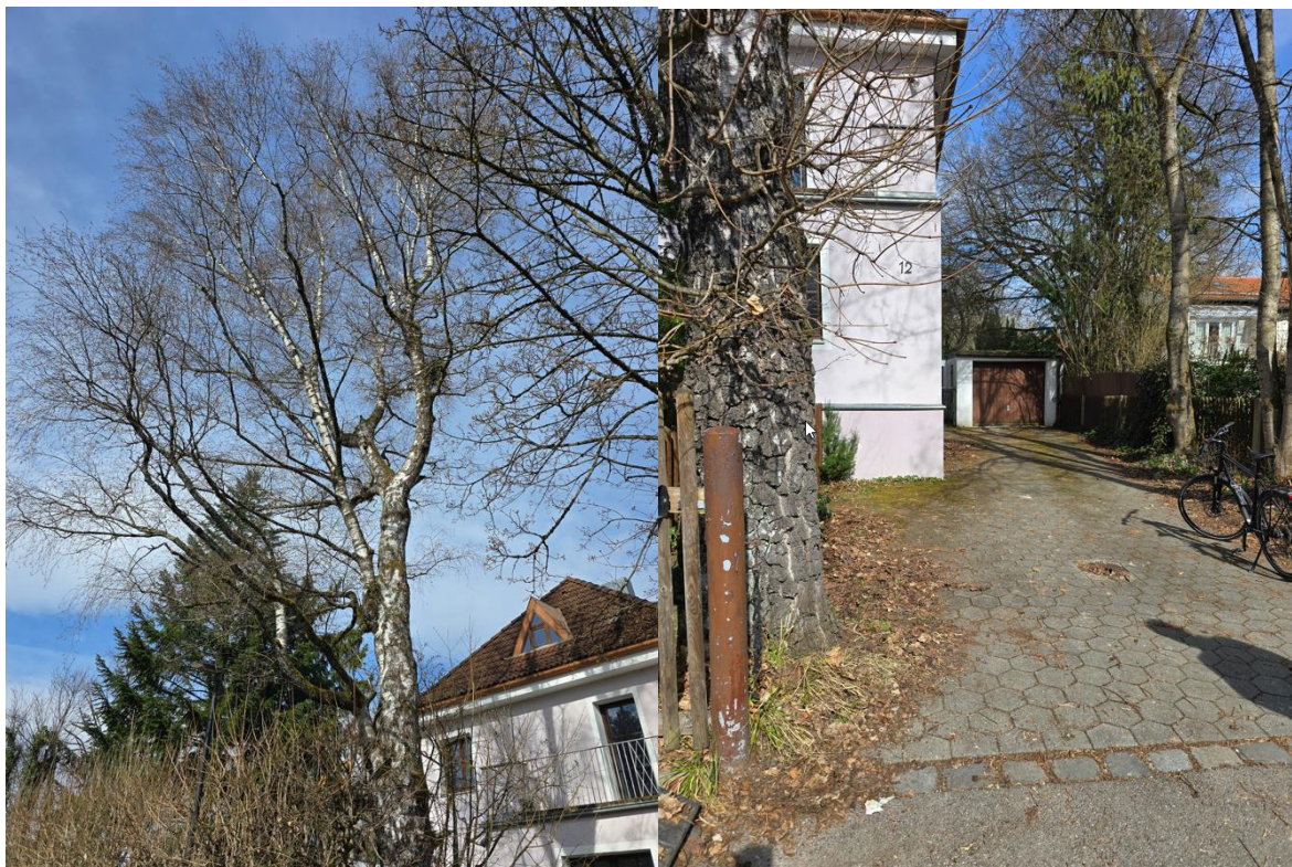
Abb. 1 und 2: Birke Nr. 1 unmittelbar in der Einfahrt mit altem Kronenbruch
