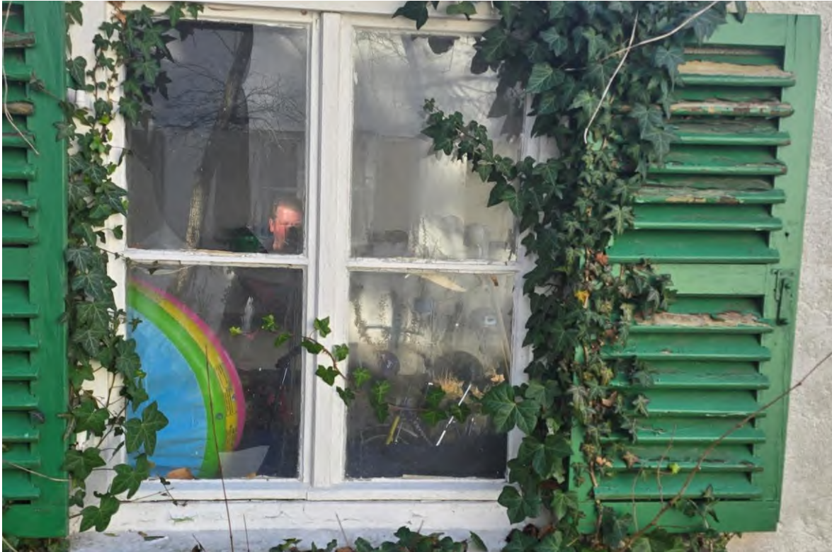
Abb. 6: Fensterladen an Bestandsgebäude im Vorhabengebiet
