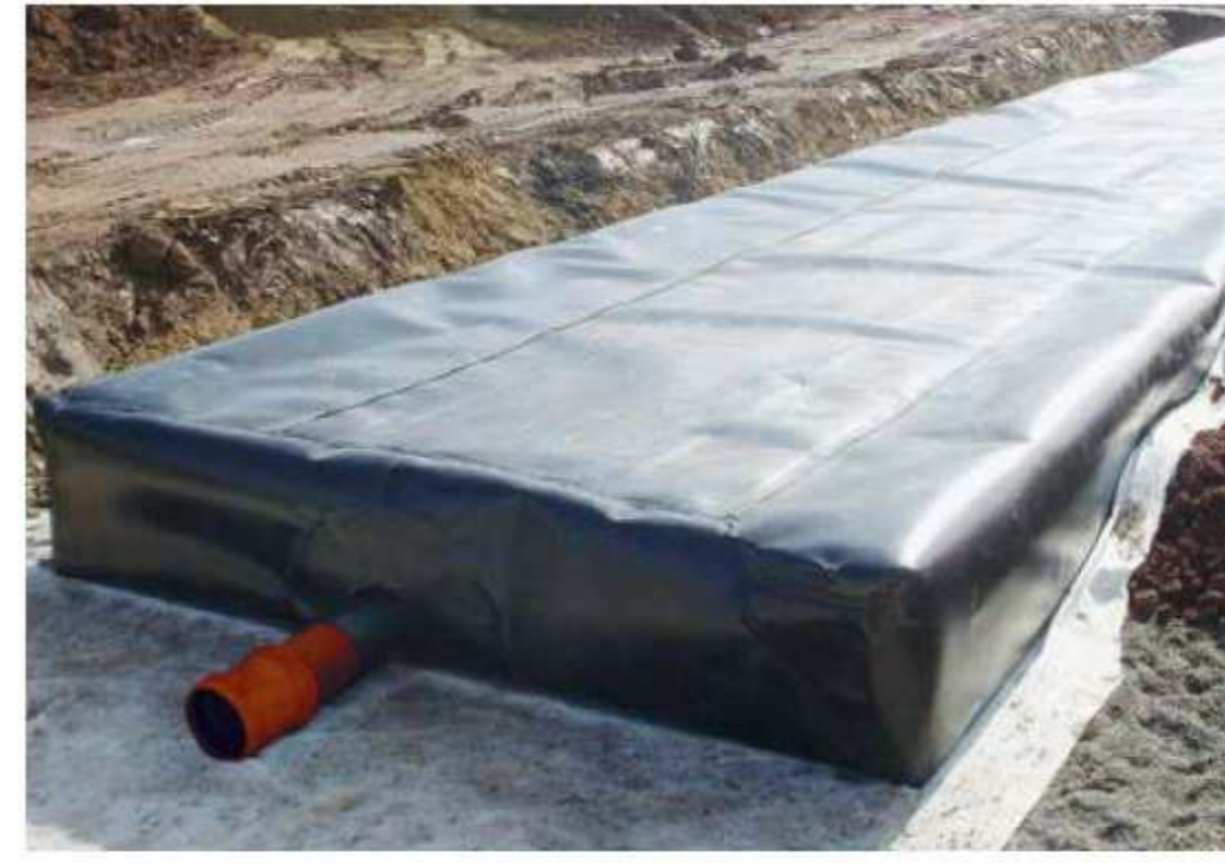
Regenwasserspeicher mit Folienummantelung
