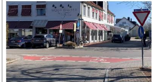
Beispiel aus Hallbergmoos: Radwegefurt mit Roteinfärbung und Fahrradpiktogrammen (jeweils eins ausgerichtet für den abbiegenden und den einbiegenden Verkehr)
