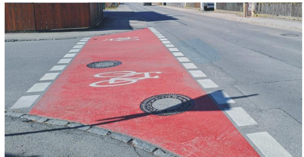
Beispiel aus Hallbergmoos: Radwegefurt mit Roteinfärbung und Fahrradpiktogrammen (jeweils eins ausgerichtet für den abbiegenden und den einbiegenden Verkehr)
