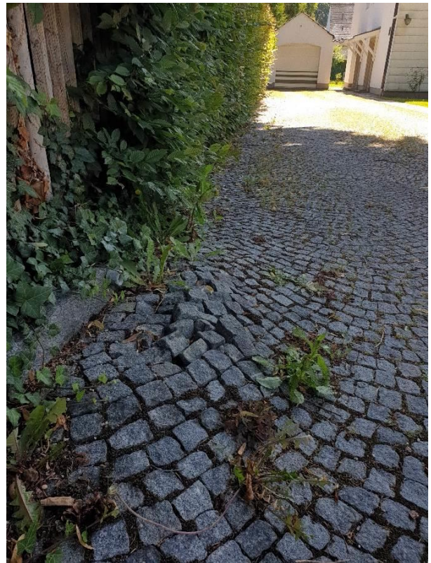
Abb. 4: Anhebungen des Pflasters
